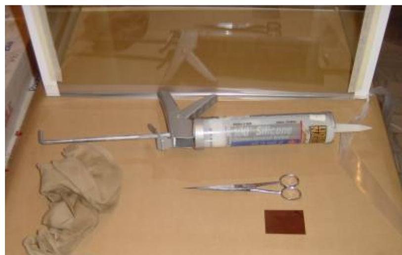
El cordón tendrá un ancho de 6 a 20mm dependiendo del grosor de los vidrios, es bueno tener a la mano una mica o plástico, cortado en el ángulo necesario para "raspar" el sobrante de silicón.
