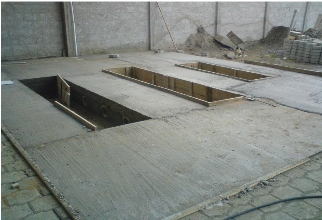
Fig. 5.2 Construcción civil de la fosa de pintura automotriz.
