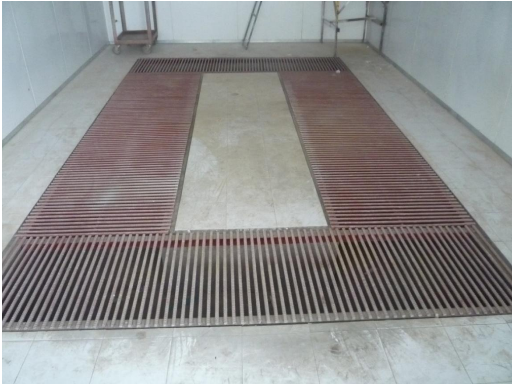
Fig. 5.18. Rejillas del piso.
