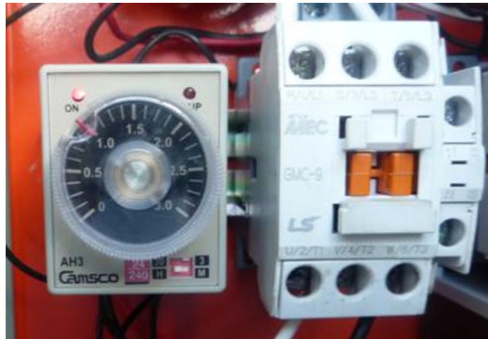
Fig. 6.6. Temporizador de la cabina de pintura.
