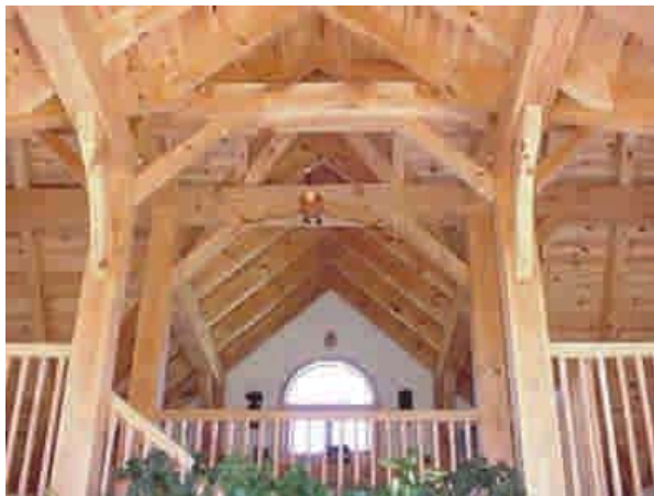
Figura 6 - 7: Conjunto de elementos estructurales, vigas y pilares a la vista en el interior.
