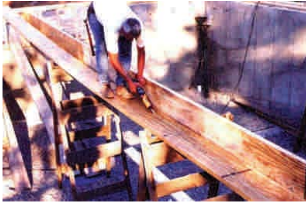
Figura 9 - 55: Armado de la viga maestra compuesta, colocación de adhesivo para madera entre las piezas que permite reforzar la unión de éstas con la colocación de clavos alternados cada 15 cm.
