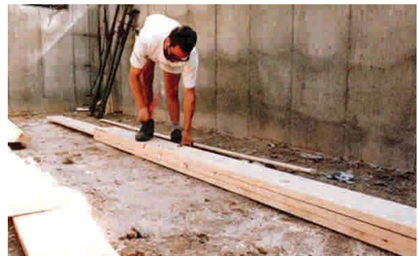
Figura 9 – 54: Presentación de las piezas de Pino radiata de grado estructural, en este caso de escuadrías de 2"x8" que conformarán la viga maestra o principal.
