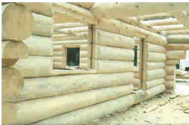
Figura 6-2: A. Vivienda construida con troncos macizos, de diámetro promedio de 30 a 35 cm.
