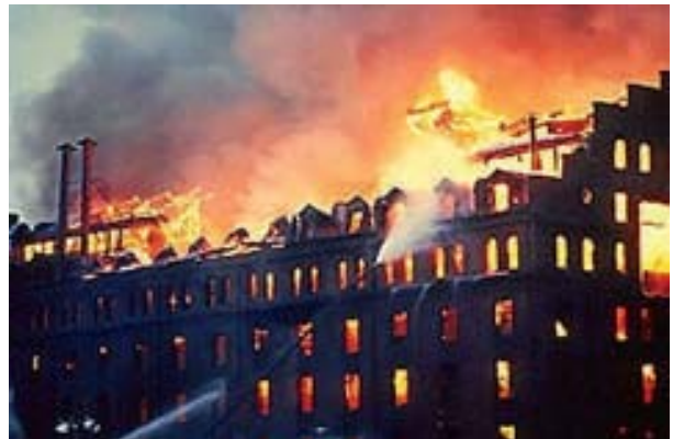
Figura 15–10: El no cumplimiento de las disposiciones mínimas en lo que a protección pasiva se refiere, provocará que la estructura de un edificio presente escasa resistencia al avance de las llamas y propagación de gases, siendo altamente probable la muerte de personas.
