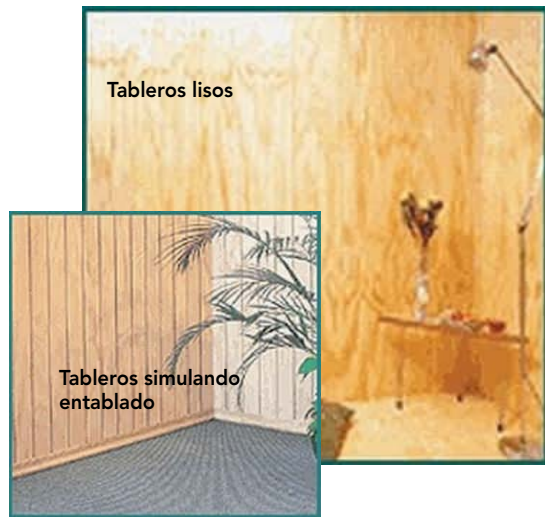
Figura 19 - 23: Revestimiento con tableros contrachapados.
