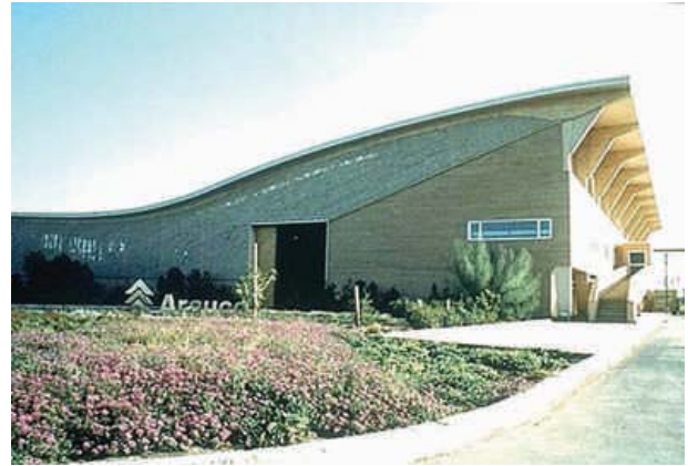
Figura 1 - 95: Aplicación de la madera laminada en estructuras de grandes luces, construcción industrial, arquitecto José Cruz Ovalle.
