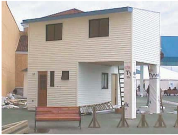
Figura 18 - 23: Revestimiento en moldura de \frac{3}{4} " x 5" tinglado, con tratamiento superficial y terminación con pintura acrílica.
