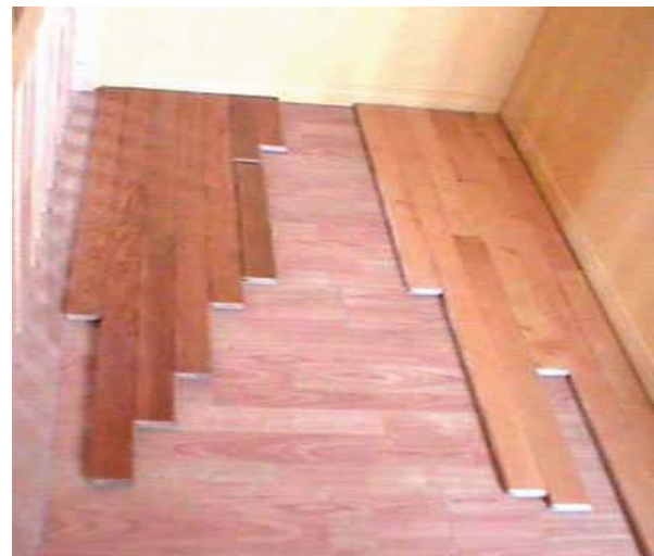
Figura 20-2: Tipos de revestimientos para pisos con distintos diseños. En la figura, solución de piso con moldura machiembrada, adherida a una base de madera.
