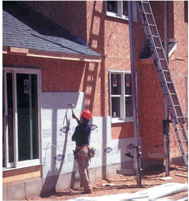
Figura 4 - 14: Las escaleras no deben ser estructuras fabricadas improvisadamente en obra. Es recomendable el uso de escaleras metálicas.
