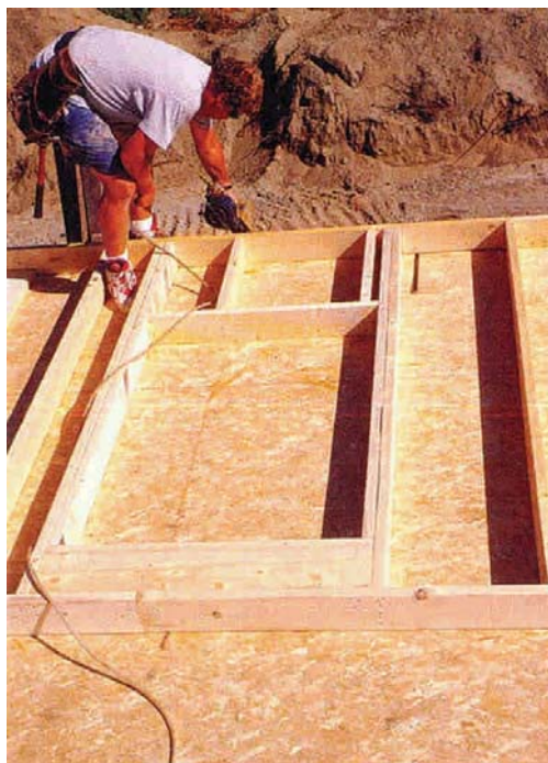
Figura 10 - 27: La calidad de la madera utilizada es esencial para la prefabricación de los entramados verticales, ya que de ello depende fundamentalmente la durabilidad y estabilidad de los elementos en servicio.
