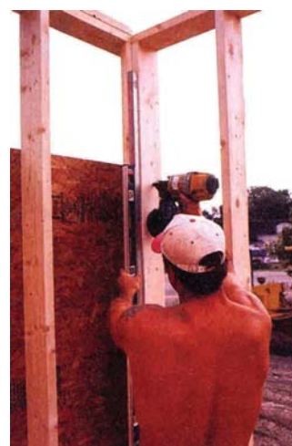
Figura 10 – 32: Clavado de un encuentro entre tabiques con control de verticalidad (nivel de mano), según la descripción anterior.
