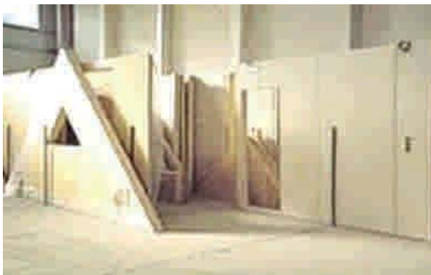
Figura 6 - 5: Estructuras preparadas (tabiques, frontones) para ser trasladadas al lugar donde se está construyendo.
