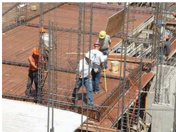
Figura 1-85: Ejemplo de aplicación de tableros contrachapados en moldajes para elementos de hormigón armado.
