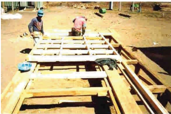
Figura 10 - 73a: Ejemplo de prefabricación de un tabique divisorio en mesa de armado en obra.
