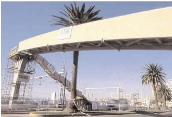
Figura 1 - 99: Pasarela peatonal ciudad de Valparaíso, arquitecto José Cruz Ovalle.
