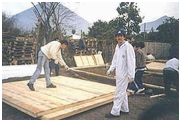
Figura 1 - 66: Mediaguas de madera construidas en contacto directo con el suelo (construcción de emergencia).
