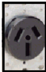
Receptáculo 240/50 amp. Típico para estufas.
