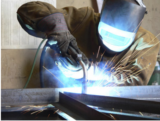
Foto 1.42 Suelda de piezas metalicas
